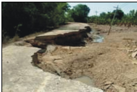
รูปที่ 1 น้ำไหลกัดเซาะโครงสร้างทางขาด (ด้านโครงสร้างถนน)
