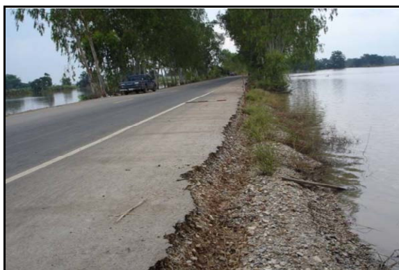
รูปที่ 9 น้ำไหลกัดเซาะคันทางชำรุดเสียหาย (ด้านคันทาง)
