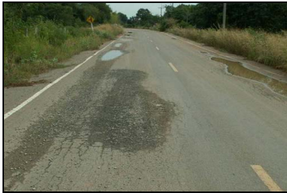
รูปที่ 6 น้ำไหลกัดเซาะผิวจราจรชำรุดเสียหาย (ด้านผิวจราจร)
