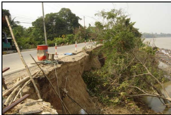
รูปที่ 8 น้ำไหลกัดเซาะคันทางชำรุดเสียหาย (ด้านคันทาง)
