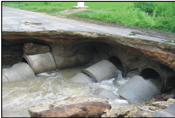
รูปที่ 4 น้ำไหลกัดเซาะบริเวณท่อลอดเหลี่ยมพัง (ด้านโครงสร้างระบายน้ำ)
