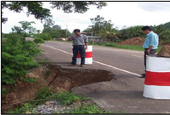
รูปที่ 10 น้ำไหลกัดเซาะคันทางและไหล่ทางชำรุดเสียหาย (ด้านคันทางและผิวจราจร)
