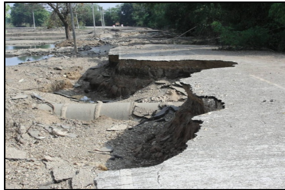
รูปที่ 4 น้ำไหลกัดเซาะบริเวณท่อลอดเหลี่ยมพัง (ด้านโครงสร้างระบายน้ำ)
