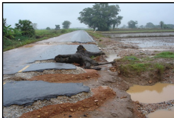
รูปที่ 1 น้ำไหลกัดเซาะโครงสร้างทางขาด (ด้านโครงสร้างถนน)
