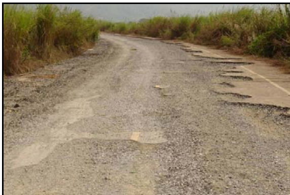
รูปที่ 5 น้ำไหลกัดเซาะผิวจราจรชำรุดเสียหาย (ด้านผิวจราจร)
